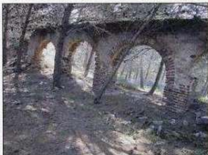
Acueducto del Cortijo Burgos.
