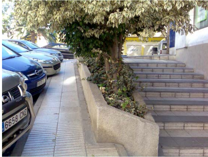
Fotografía 6 Vehículos obstaculizando rampa. C/ Aguas
