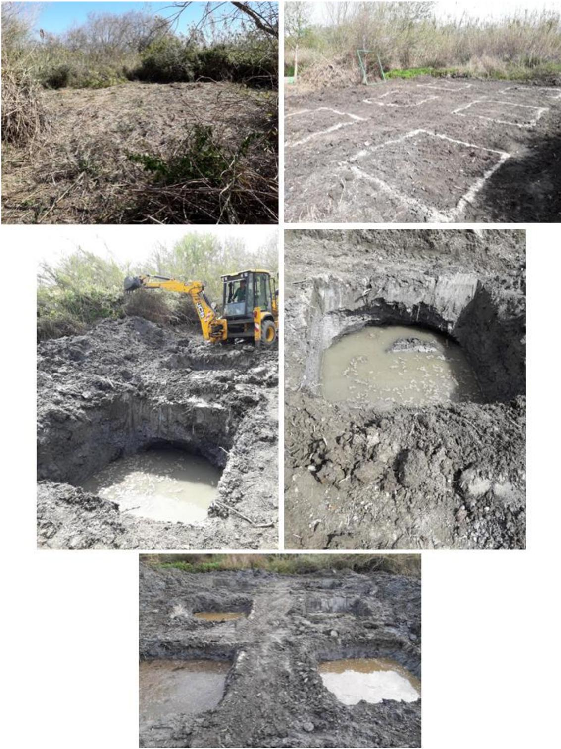
Figura 12. Proceso de excavación de las Lagunas experimentales para la experimentación en condiciones naturales semicontroladas en lagunas de reciente creación.
